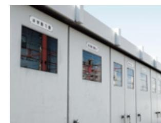
在屋顶的电气柜中安装无线单元，就能通过无线方式将用电量数据等发送到办公室等处，不需要实施配线工程。
